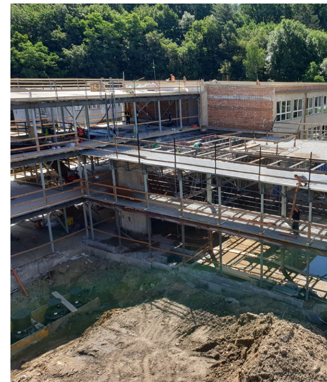
Stavbaři museli celou budovu nejprve odstroit.
