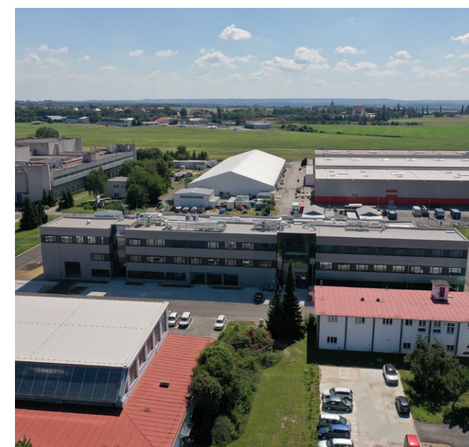
Do nové budovy se právě stěhuje vybavení.
