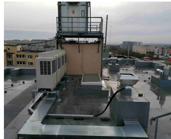
Střecha budovy je zázemím pro moderní technologie.
