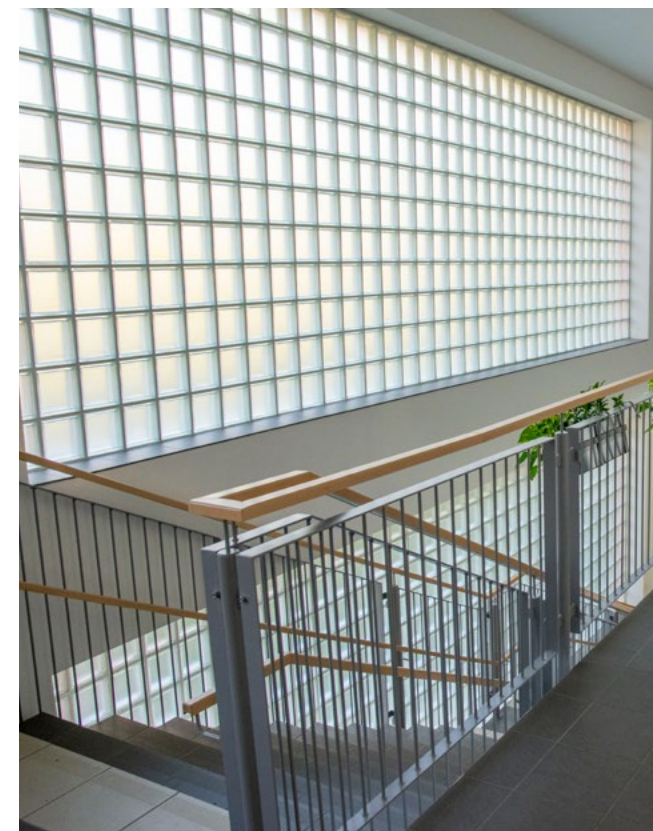
Kromě oken zajišťují přísun denního světla i luxfery.
