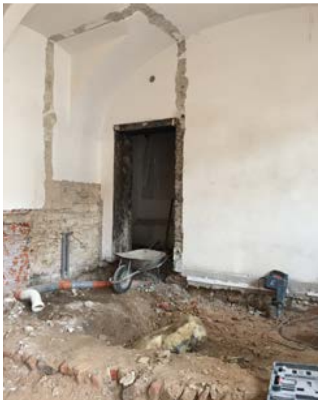
Prostory centra bylo nutné nejdříve zrekonstruovat a vybavit.
