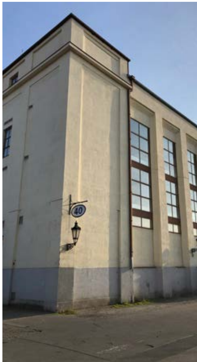
Budova před rekonstrukcí, v jejím průběhu a po skončení.
