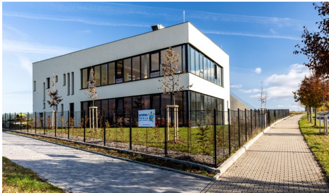
Nová budova mateřské školy je díky velkým oknům prosvětlená a propojená s okolím.
