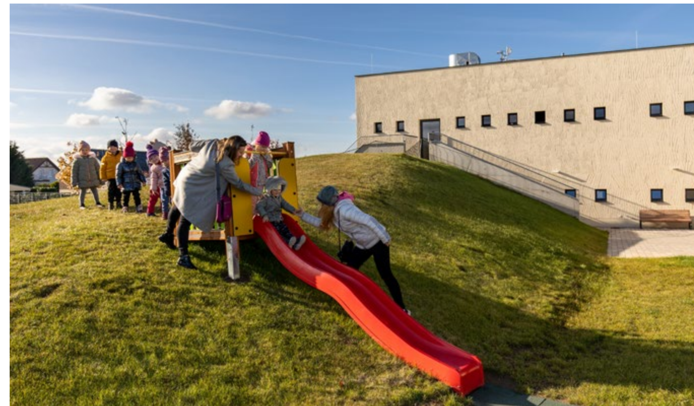
Budova i zahrada dobře využívají profil pozemku.
