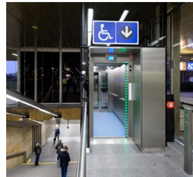
Nový výtah do stanice metra Opatov.
