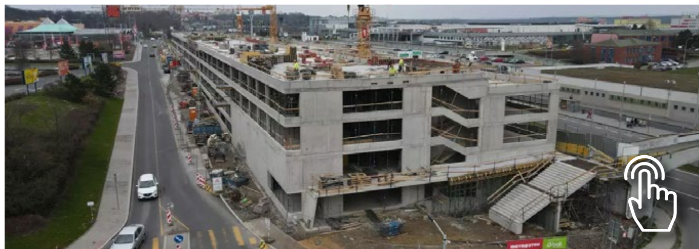
Hrubá stavba parkovacího domu už stojí.
