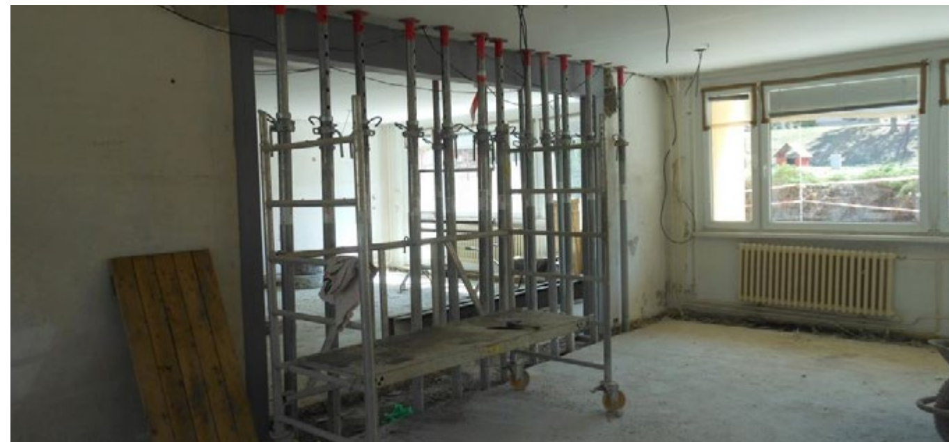
Při rekonstrukci se vnitřní prostory propojily a výrazně prosvětlyly.
