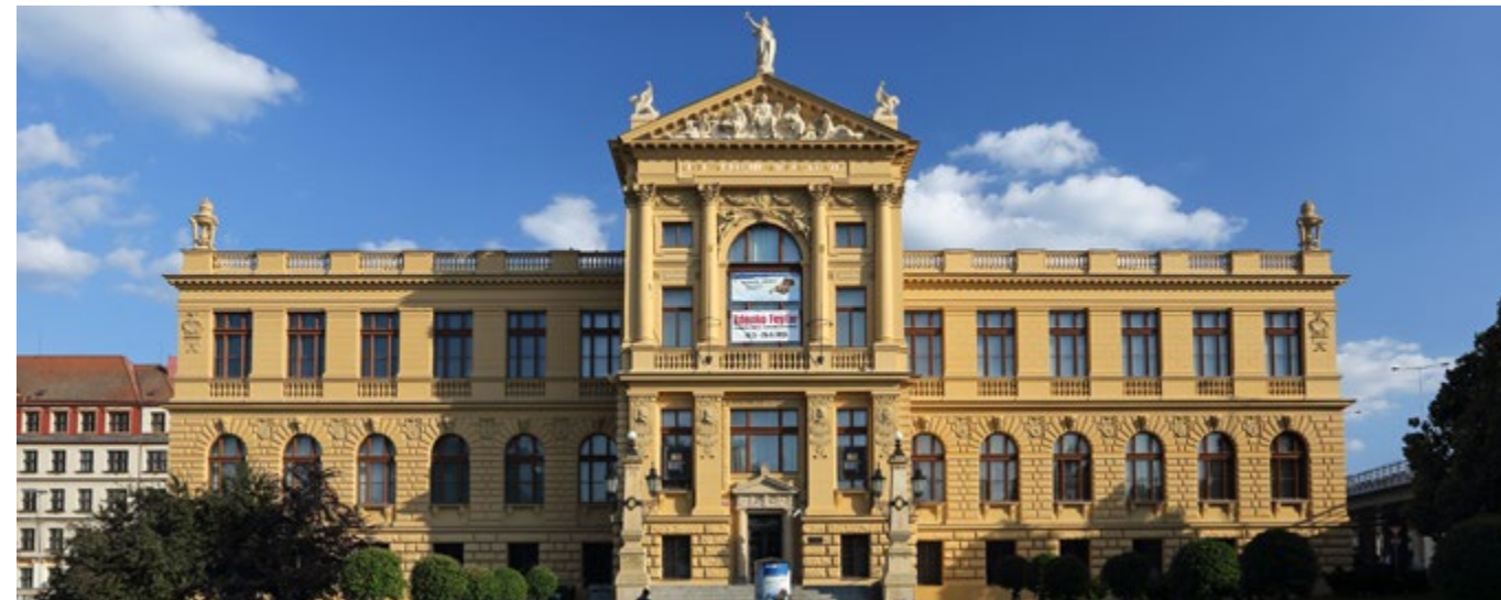
Interiér historického objektu hlavní budovy Muzea hlavního města Prahy na Florenci nyní prochází rekonstrukcí.
