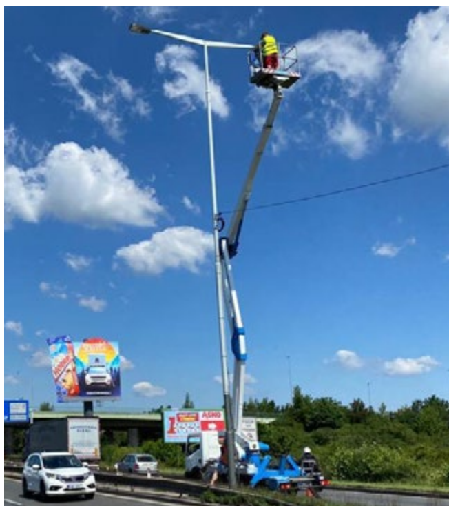
Výměna svítidel probíhala za plného provozu.
