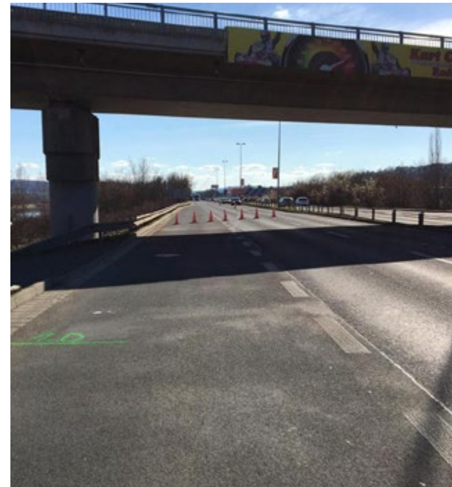
Stavební práce na silnici již začaly.
