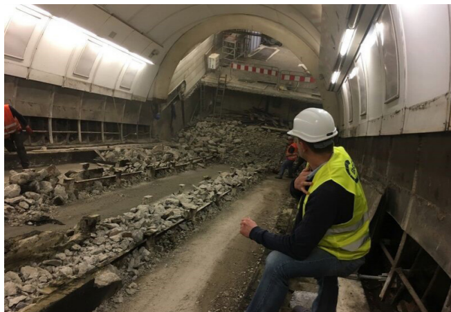
Práce na výměně eskalátorů
